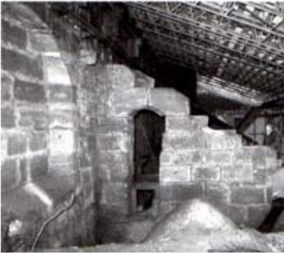
Stützdreieck über dem Seitenschiff
